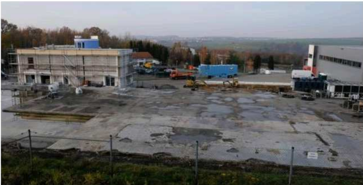
Bleibt bis auf Weiteres potenzielles Baufeld: die Bodenplatte der beim Brand zerstörten GTO-Halle. Links das bald sanierte und modernisierte Sanitärgebäude, rechts der vom Brand nicht betroffene Betriebsteil. Foto: Franko Martin
